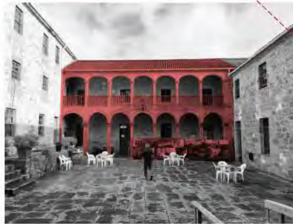
Vistas de las fachadas del claustro en su estado actual
