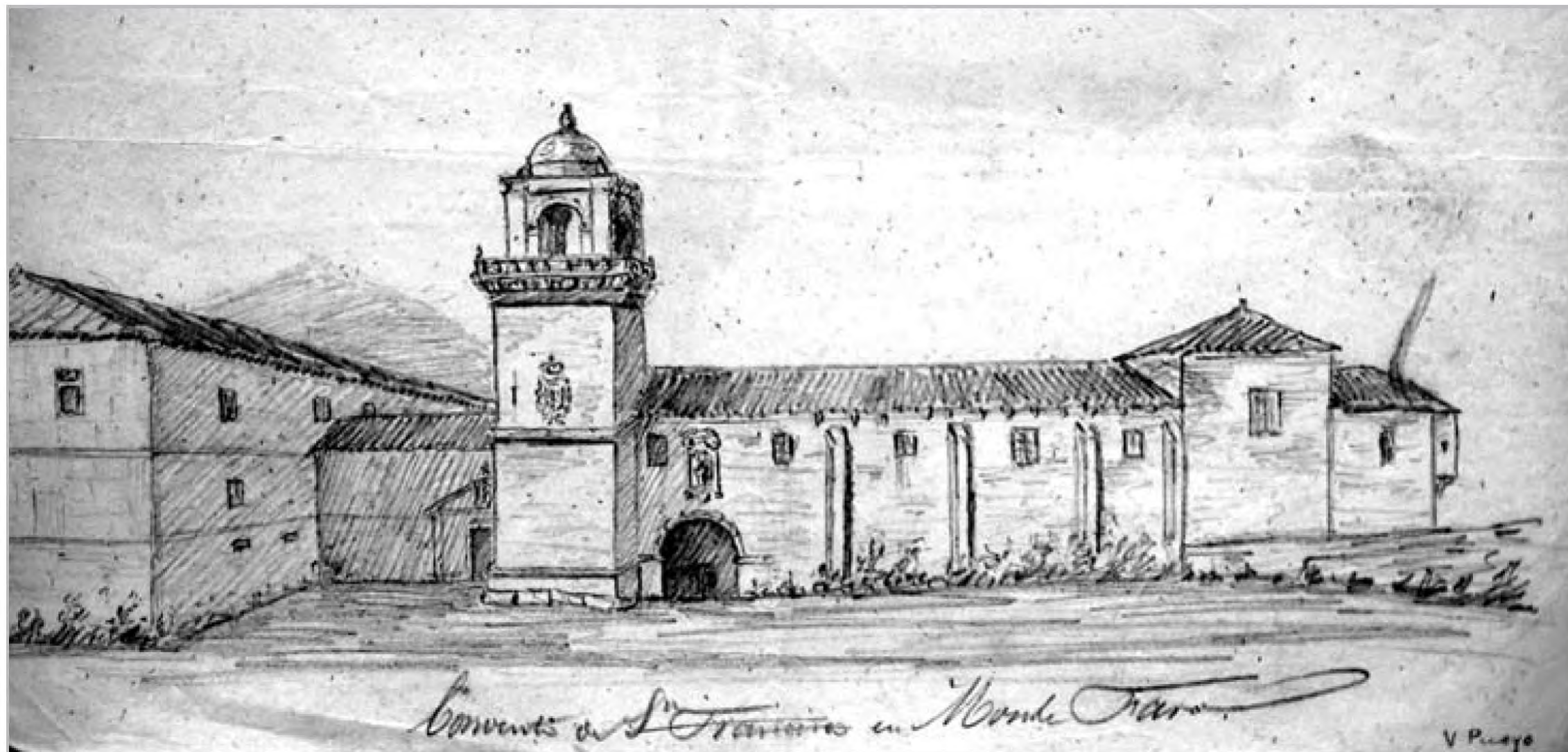
Convento de Montefaro. Vicente Pueyo (c.1859)
