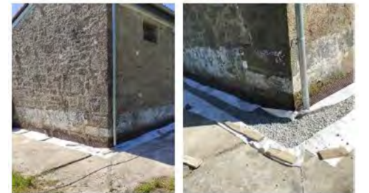
Sistema de evacuación de pluviales realizado en las últimas intervenciones
